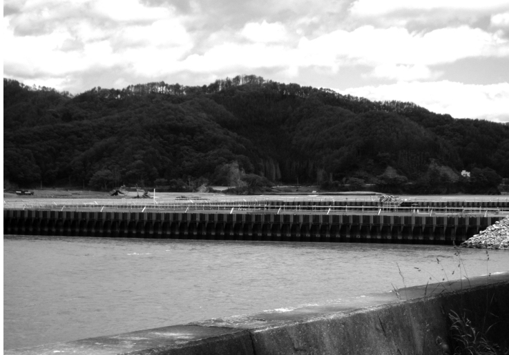
▲工事のための水門
