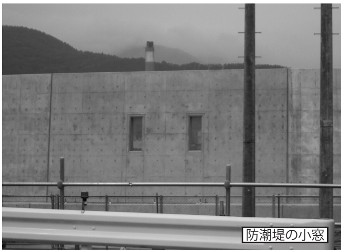
新たに造られた防潮堤
