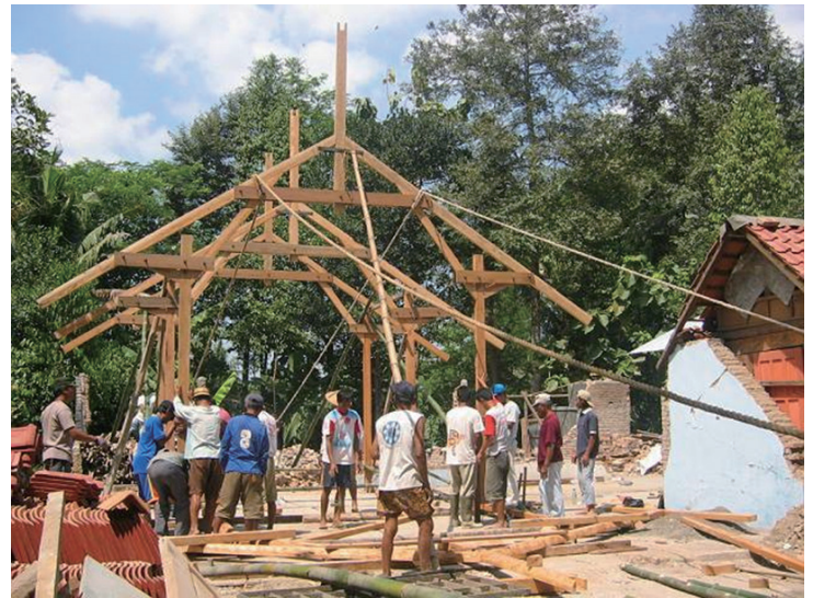
▲ゴトンロヨンで耐震住宅を建てる(2005年)
